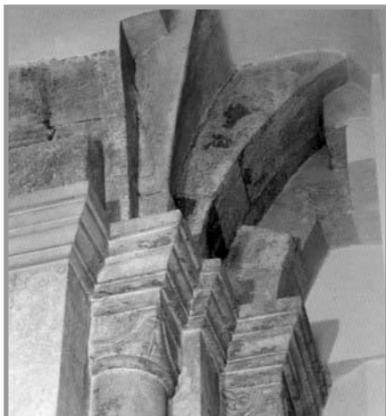
Kapitelle der romanischen Basilika (um 1177), freigelegt in der Romanischen Kapelle
